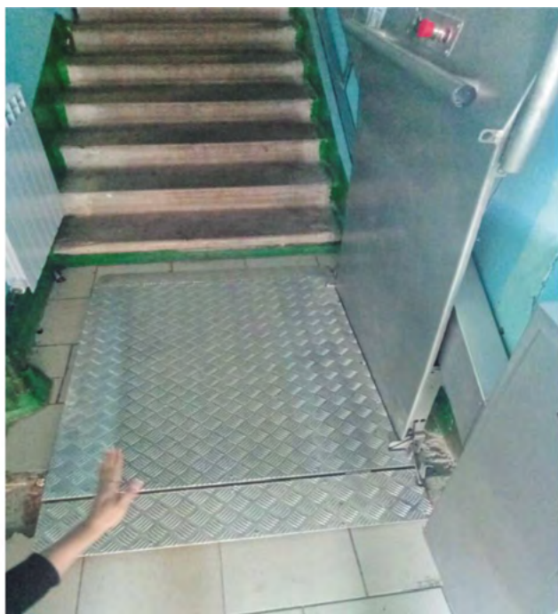
Подъемная платформа для инвалидов «Стриж-100» с дополнительной опцией для автоматического поднимания и опускания в ЖСПК № 41 г. Светлогорска
