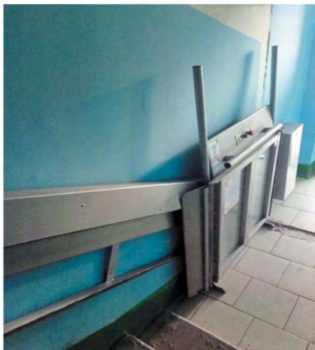
Подъемная платформа для инвалидов «Стриж-100» с дополнительной опцией для автоматического поднимания и опускания в ЖСПК № 41 г. Светлогорска
