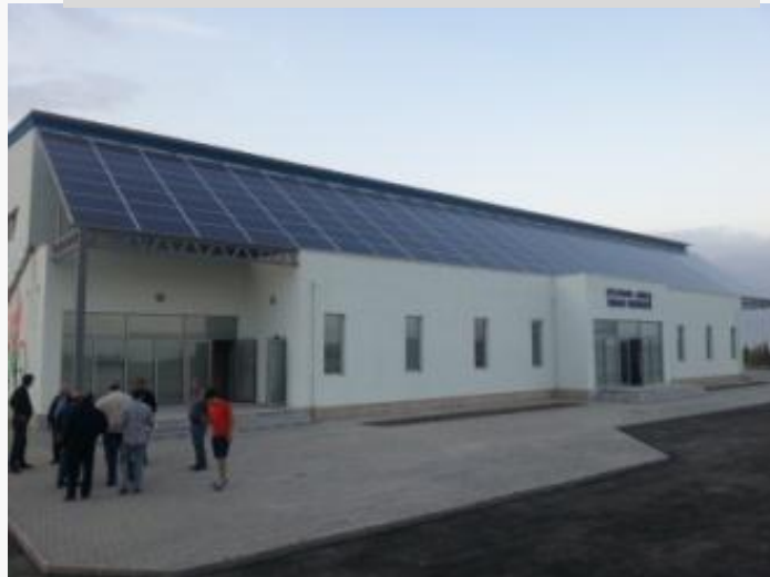
Спорткомплекс в Бейлагане (70 кВт эл., 90 кВт тепл.g)
