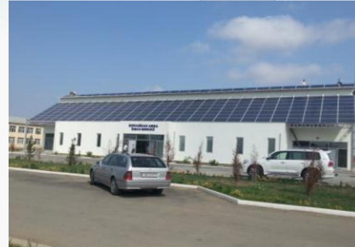
Спорткомплекс в Масаллы (70 кВт эл., 90 кВт тепл.)
