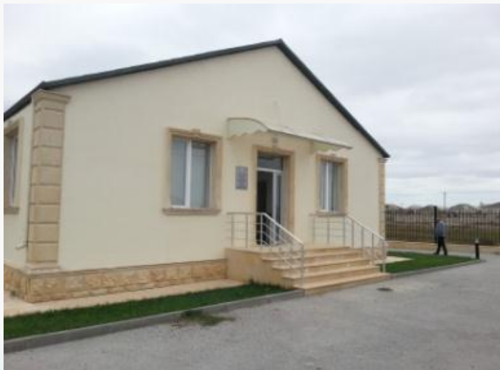
Амбулатория в Говсанах (10 кВт эл., 20 кВт тепл.)
