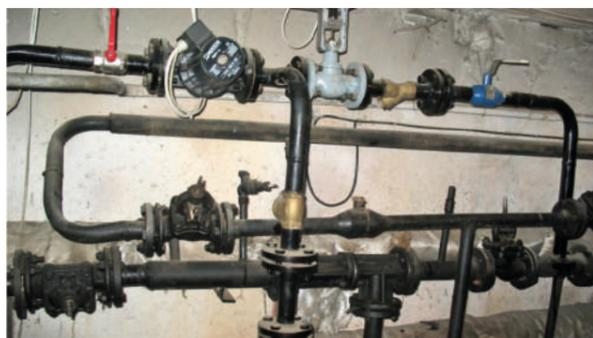
и горячую воду, теплоноситель с ТЭЦ проходит через тепловой узел здания (всего в нашем большом доме 7 тепловых узлов) – они установлены у нас в подвале (см. фото).
