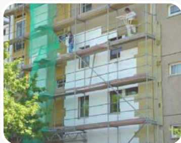
Теплоизоляция
